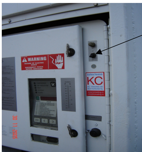
Bild 7 -- Ein/Aus-Schalter des HKA
