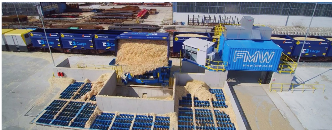
Abbildung 12 Entladung mittels stationärer Entladeanlage
