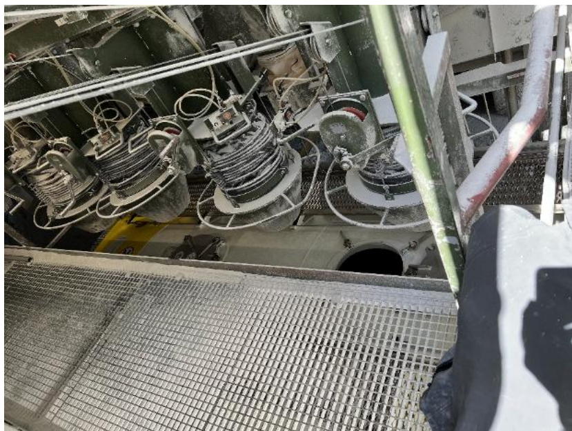
Abbildung 21 Beladen des Containers
