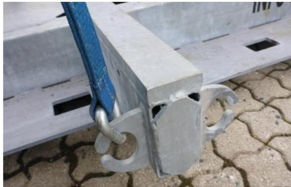
Es gibt eine Version dieser Aufnahme in Form eines nach unten offenen C-Ringes. Diese Version erfordert, dass der Dreieckshaken zunächst von unten eingeschoben wird. Die darauffolgende Drehung um 180 Grad nach oben führt zur vorgeschriebenen Endposition.
