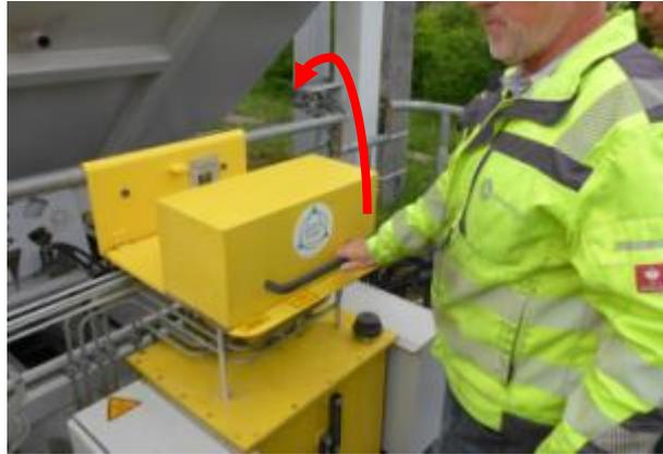
Den Vierkantschlüssel oder das Vorhängeschloss in „Position 2 – geöffnet“ in die Lasche einhängen und damit den Deckel des Bedienpultes fixieren.
