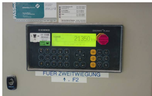
Abbildung 10: Variante G, Während der Befüllung C.1.2.
